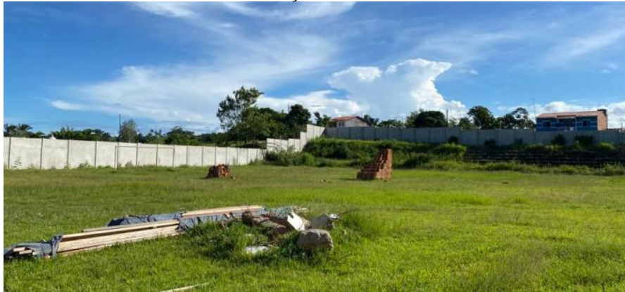
Foto 02 – Construção de vestiário.
