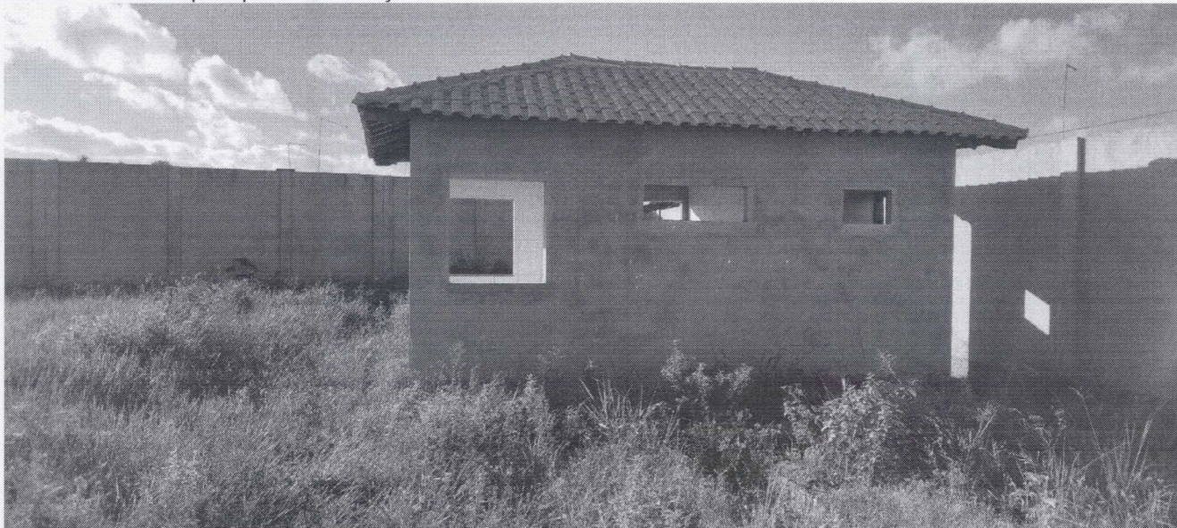
Foto 01 – Vista do quiosque em construção.
