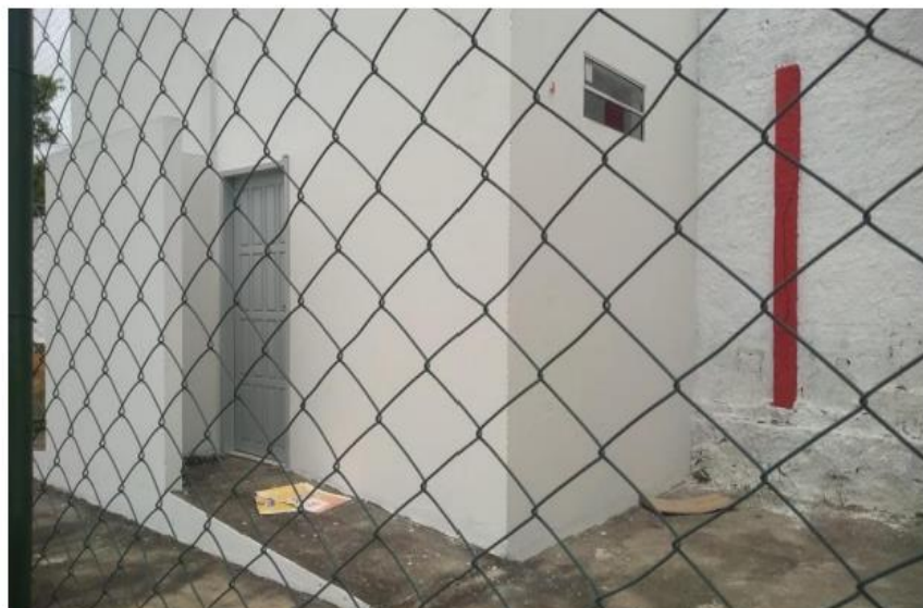
Fig 06: Reforma dos Sanitários Feminino
