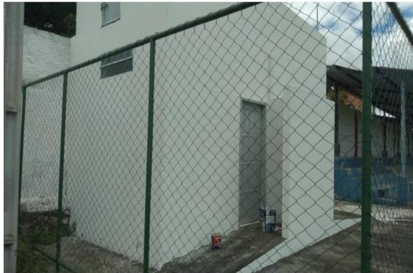
Fig 05: Reforma dos Sanitários Masculino
