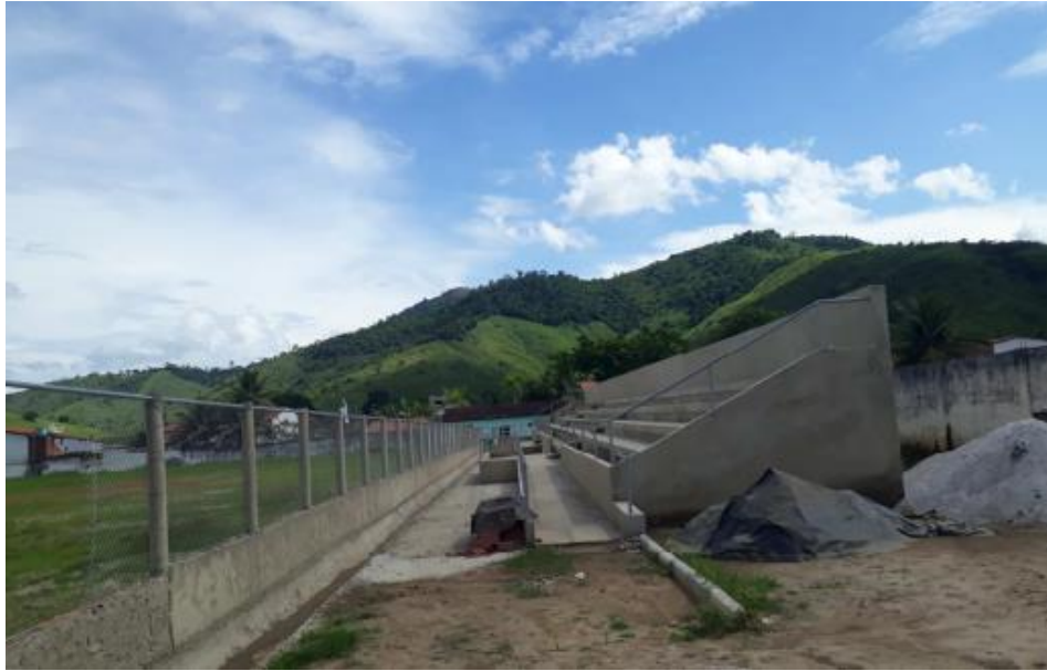
Foto 02 – Execução de acesso e alambrado.
