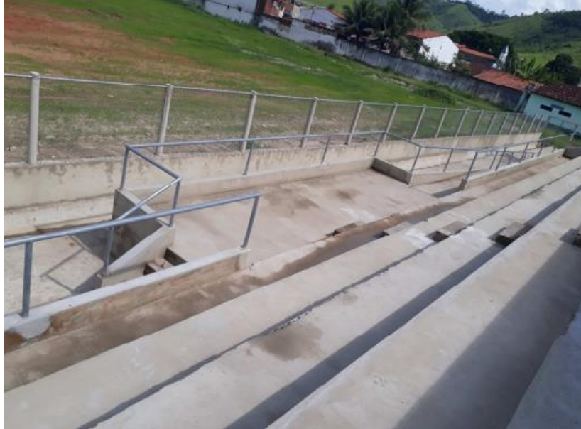
Foto 03 – Execução de arquibancada, acesso e alambrado.
