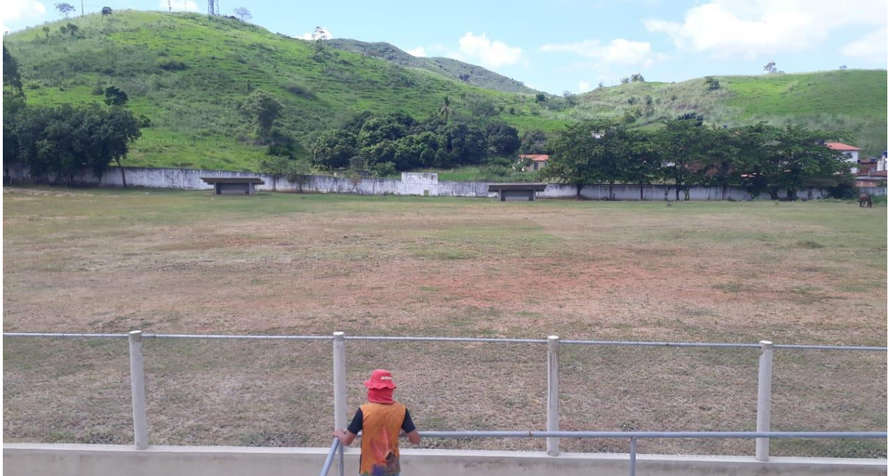
Foto 03 – Execução de arquibancada, acesso e alambrado.
