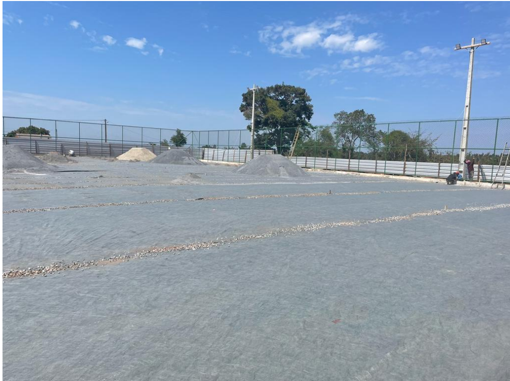
Foto 02 – Colocação de tela de arame galvanizado e execução de pavimentação.
