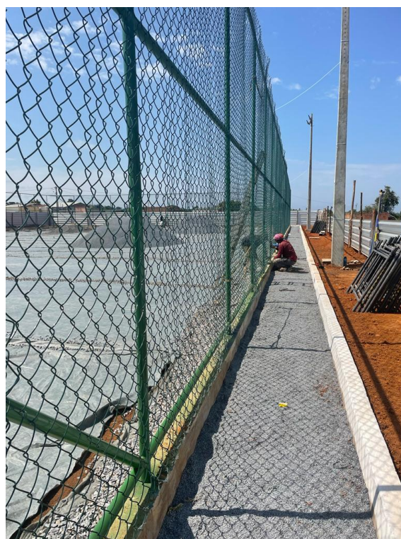
Foto 02 – Colocação de tela de arame galvanizado e execução de pavimentação.
