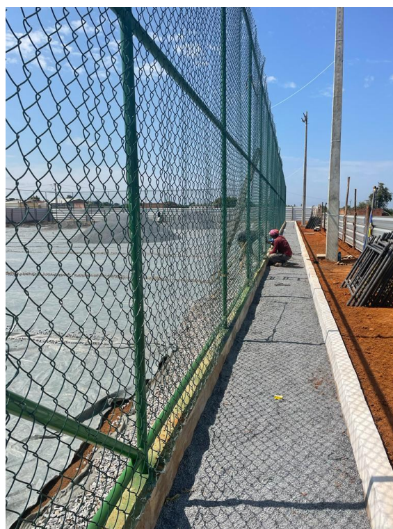
Foto 02 – Colocação de tela de arame galvanizado.
