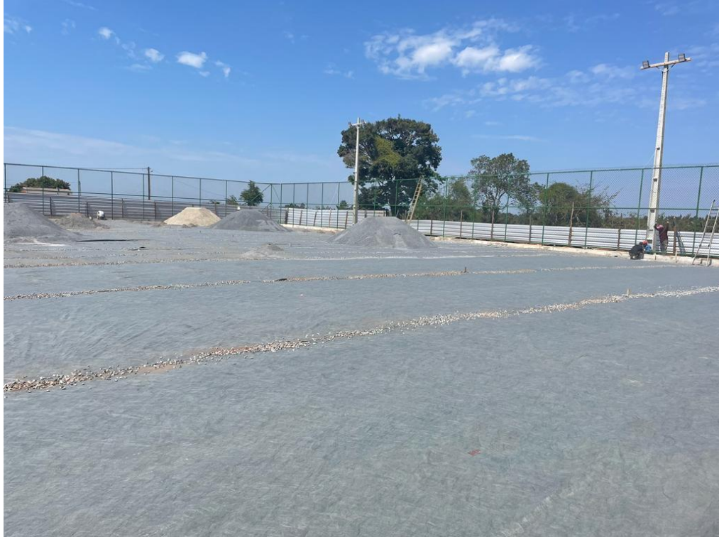
Foto 02 – Colocação de tela de arame galvanizado.
