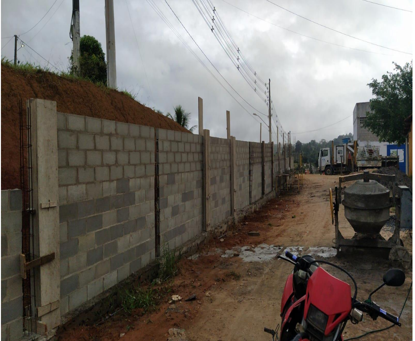
Foto 01 – Construção do muro
