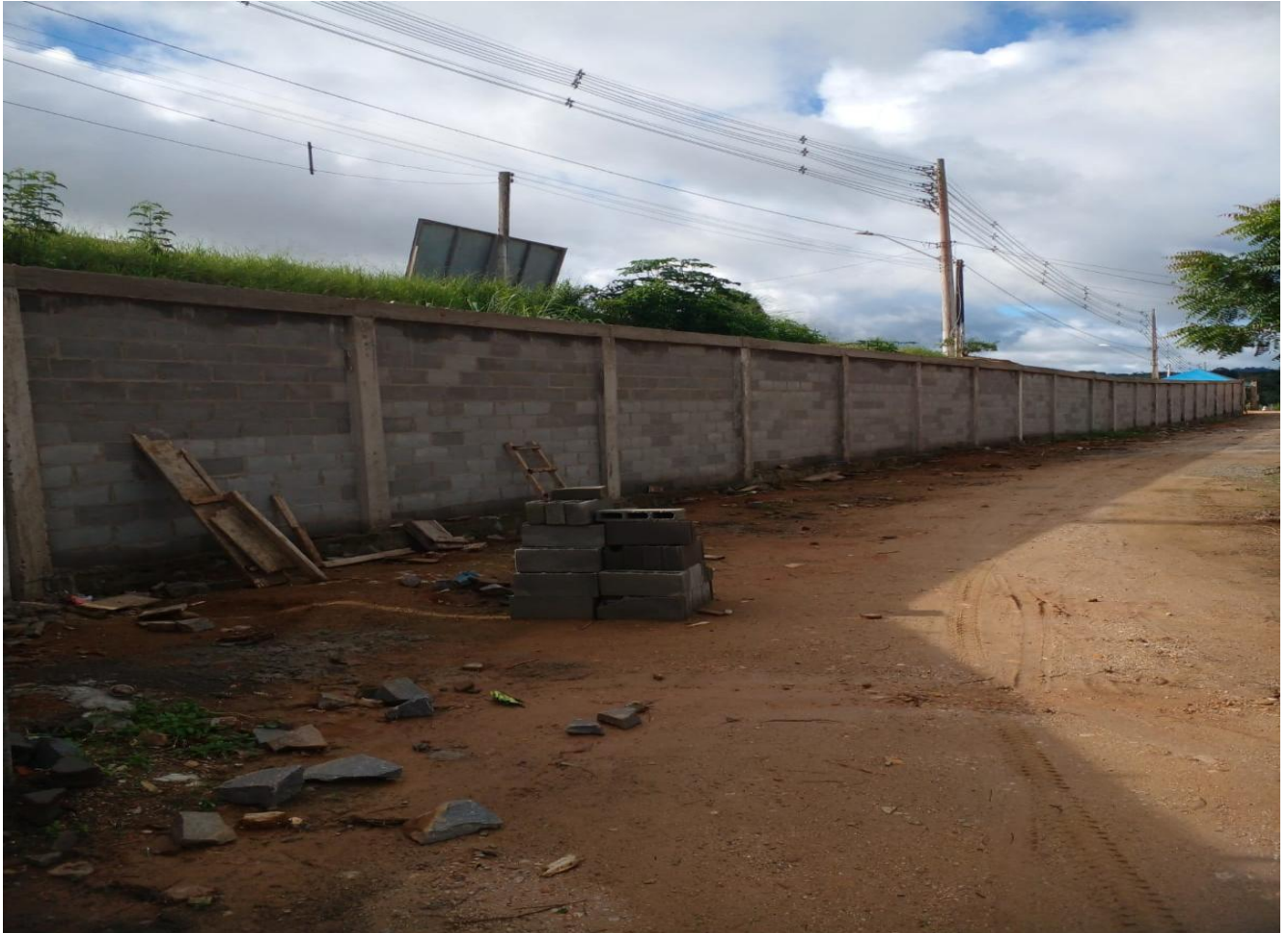
Foto 01 – Construção do muro
