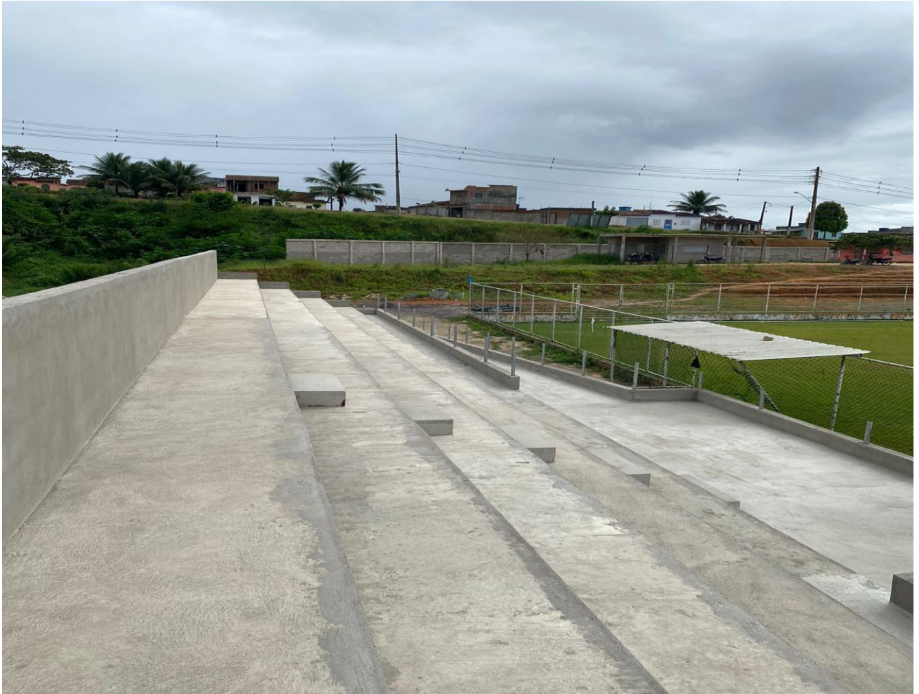
Foto 02 – Construção de arquibancada
