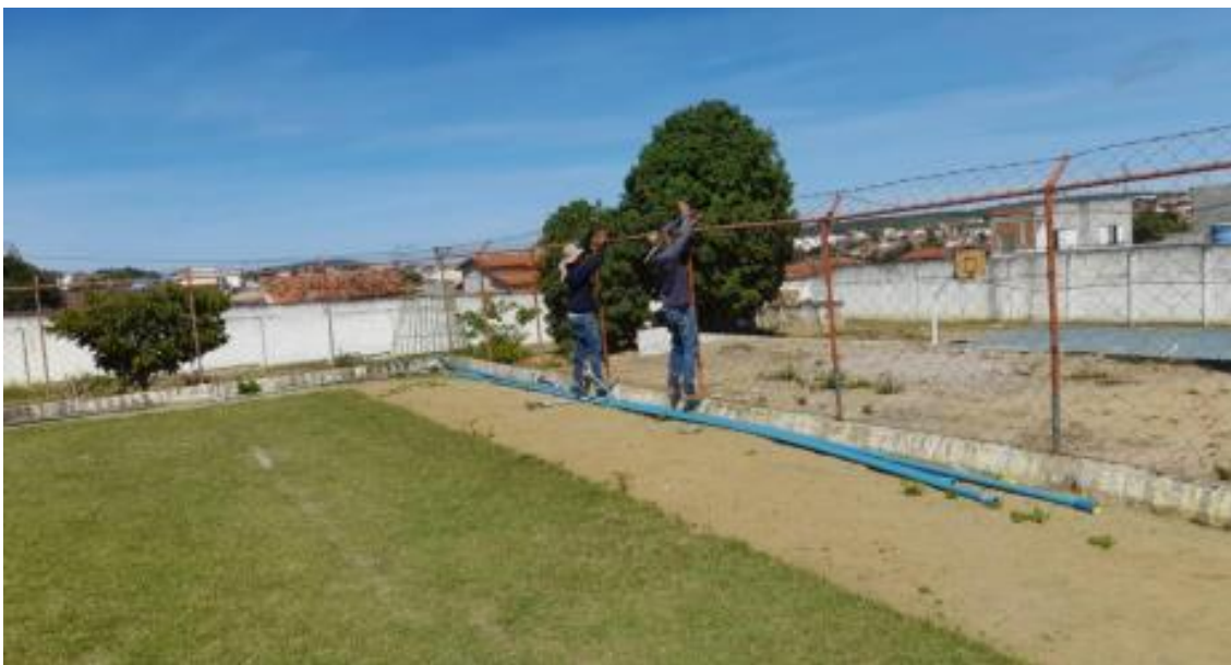
Foto 02 – Remoção de tela metálica do alambrado.
