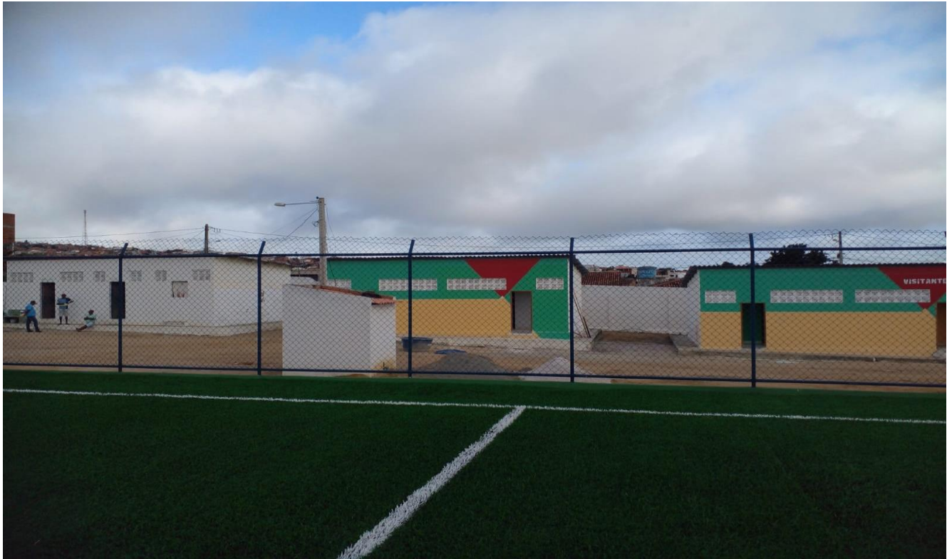
Foto 01 – Instalação do Alambrado.
