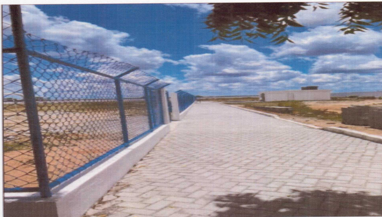
Foto 04 – Execução do Alambrado.
