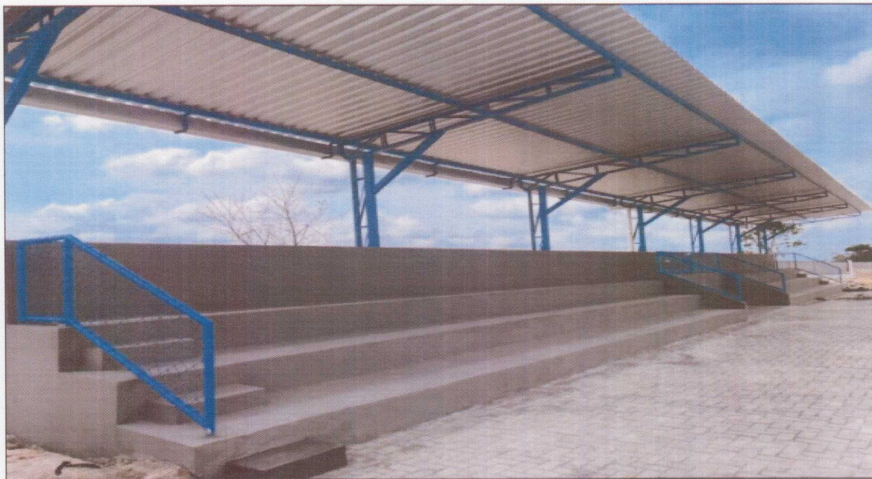
Foto 01 – Execução da Arquibancada.
