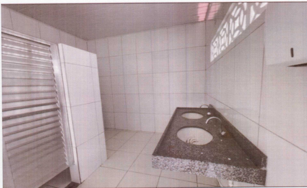
Foto 03 – Execução da Reforma do Vestiário área interna.
