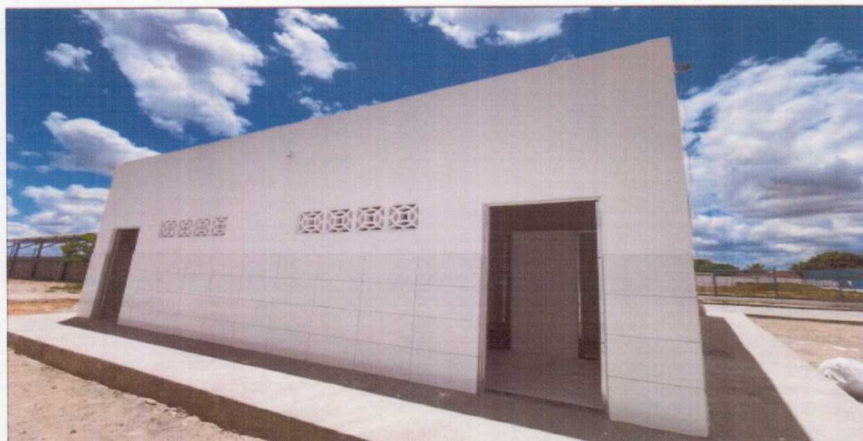
Foto 02 – Execução da Reforma vestiário área externa.
