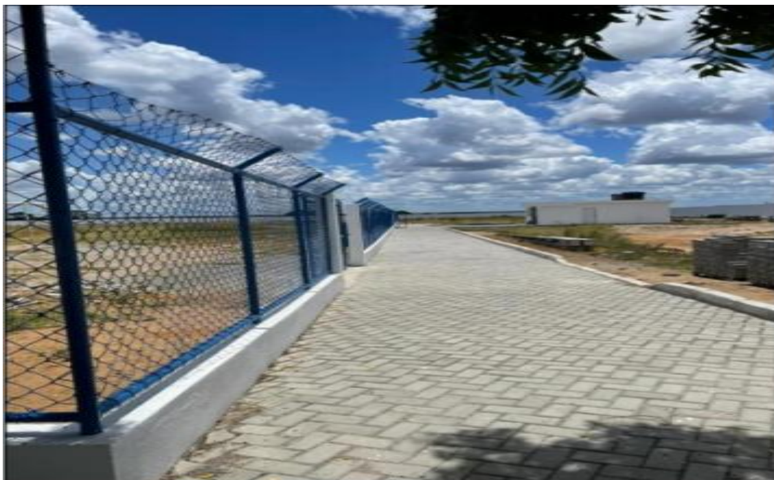
Foto 04 – Execução do Alambrado.
