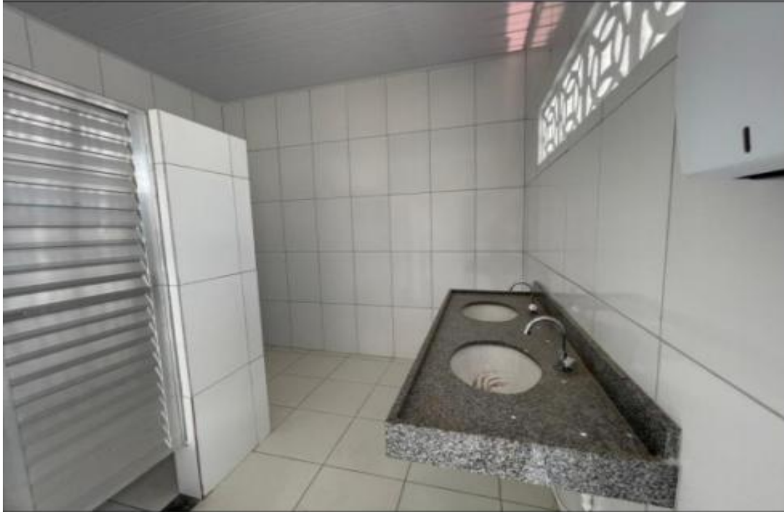
Foto 03 – Execução da Reforma do Vestiário área interna.
