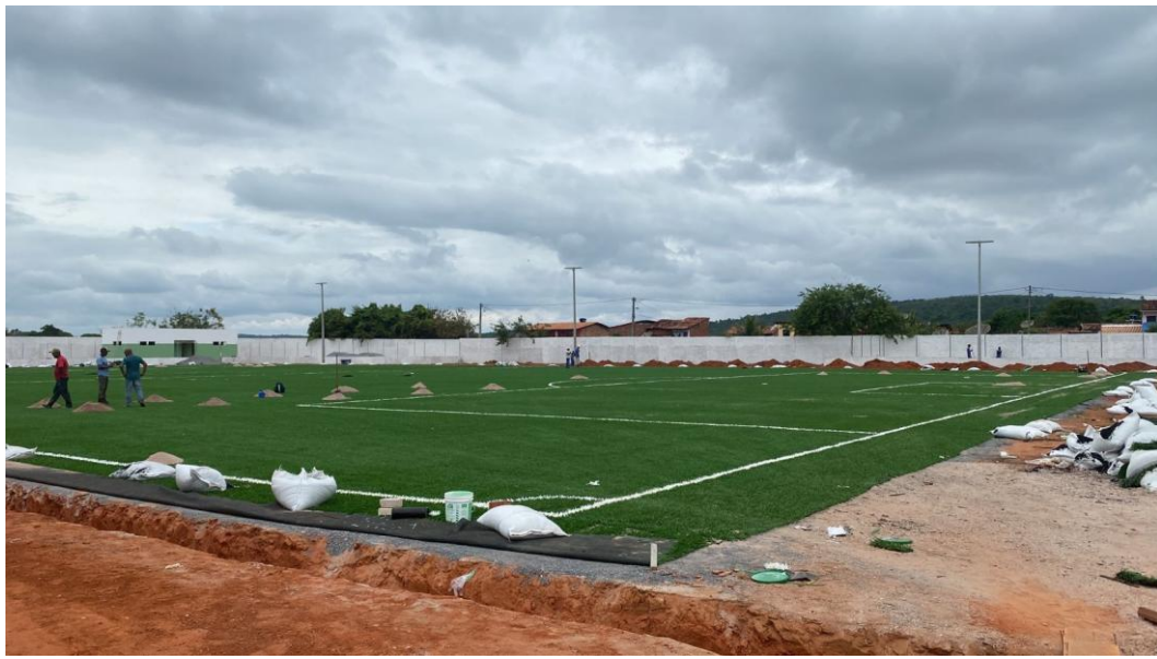
Foto 02 – INSTALAÇÃO DE POSTES.
