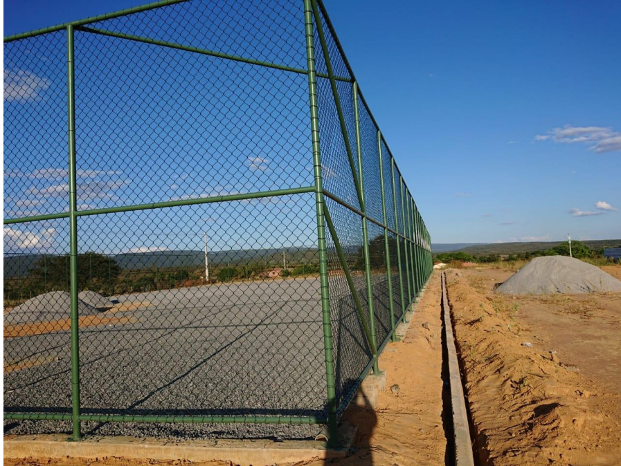
Foto 02 – Nivelamento com brita para execução de grama sintética.
