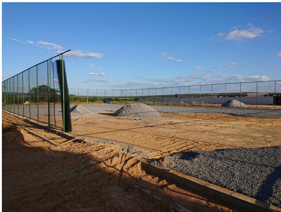
Foto 02 – Nivelamento com brita para execução de grama sintética.
