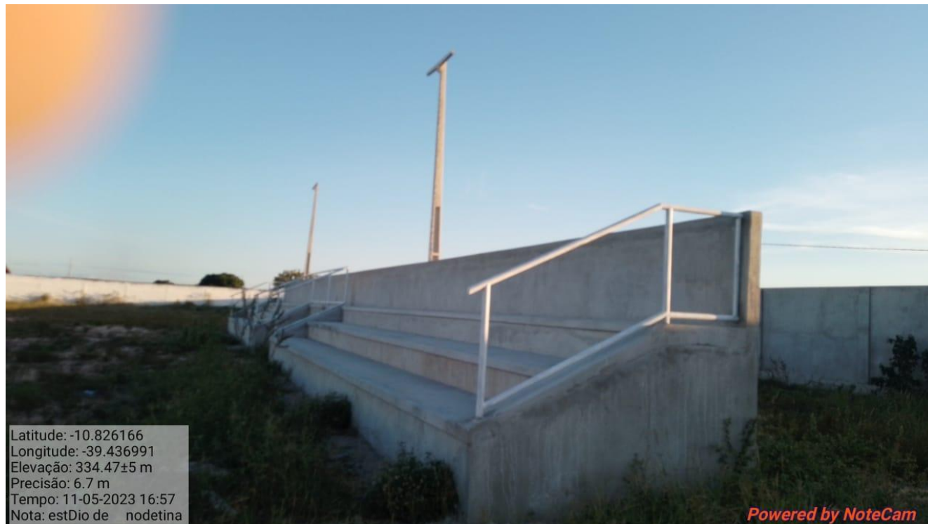
Foto 03 – Construção da arquibancada.
