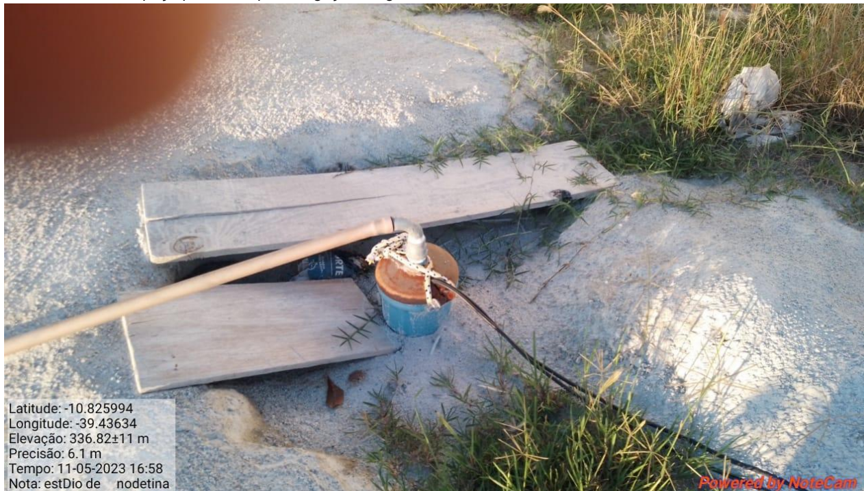
Foto 05 – Vista do poço perfurado para irrigação do gramado.
