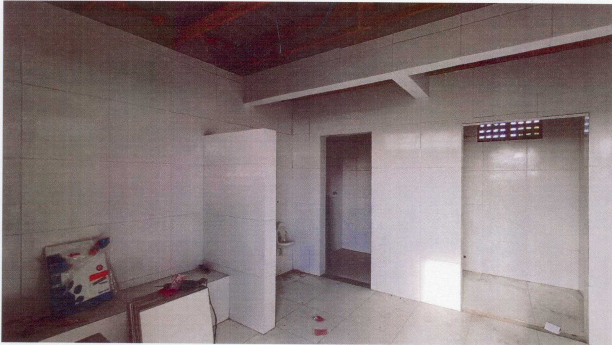
Foto 03 – Vista Interna dos vestiários.
