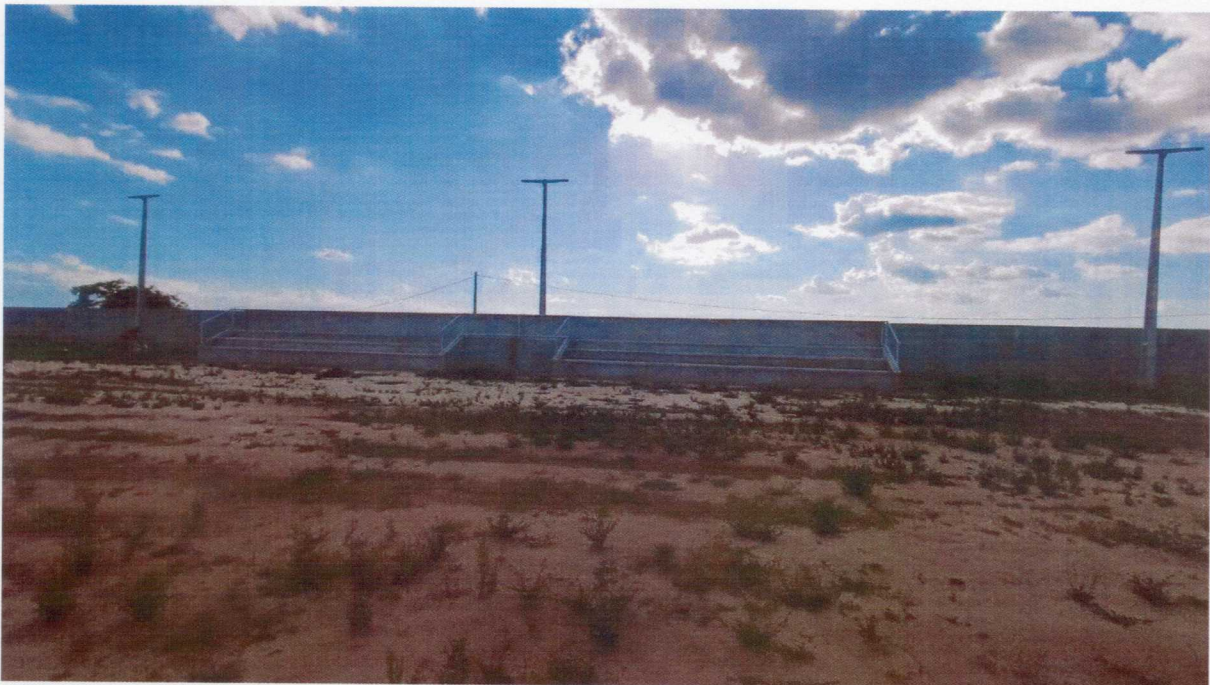
Foto 06 – Vista da Arquibancada e Postes do sistema de iluminação.
