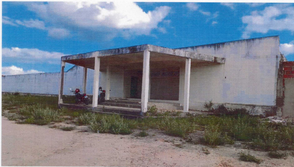
Foto 01 – Vista da atual entrada do Estádio.
