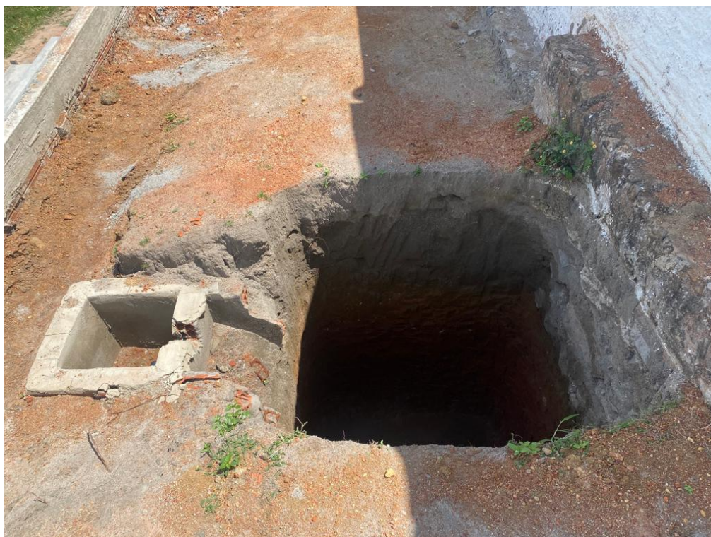
Foto 02 – EXECUÇÃO DE VALA PARA ILUMINAÇÃO.
