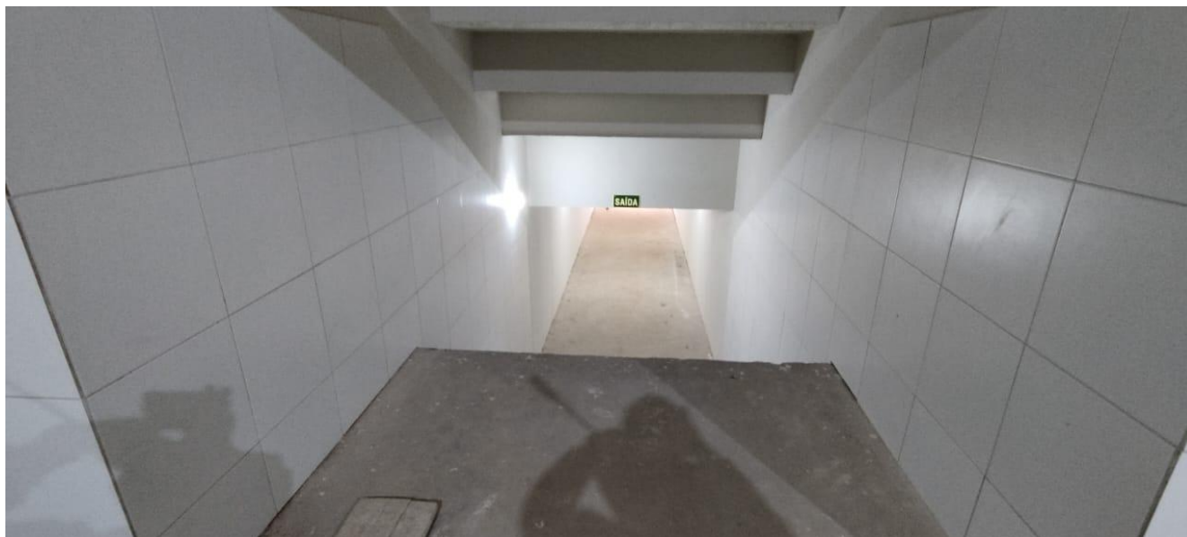
Foto 07 – Vista do Túnel de acesso ao campo de jogo.
