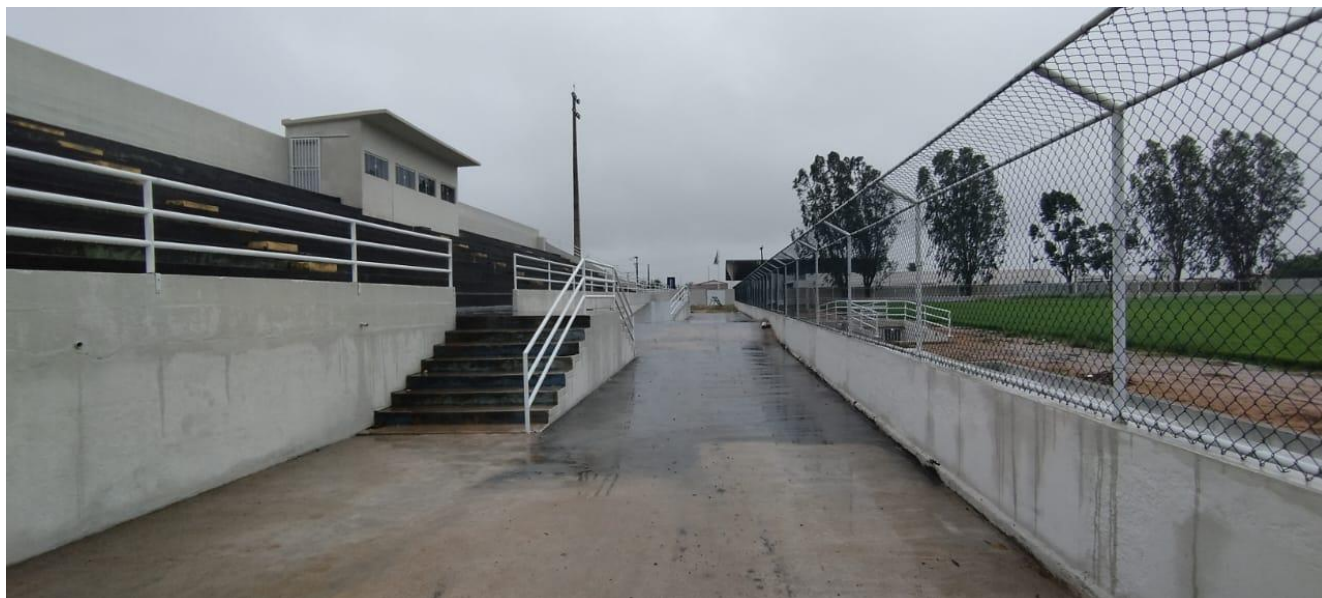
Foto 05 – Vista da Arquibancada e dos respectivos acessos e do Alambrado.
