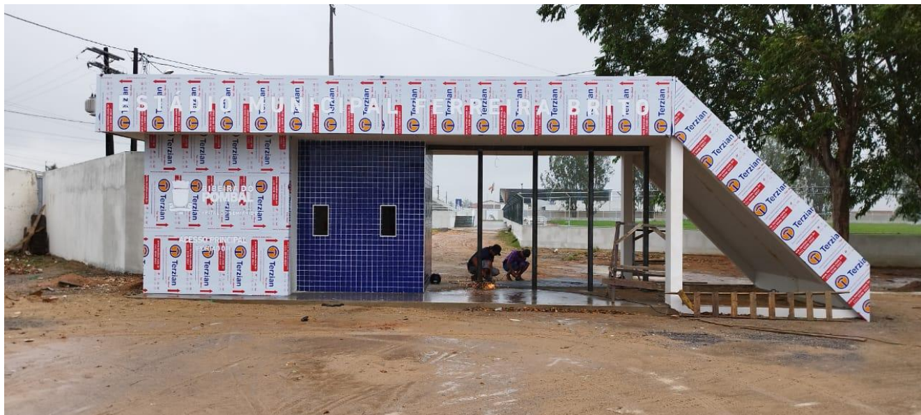
Foto 03 – Vista do pórtico de entrada e bilheteria.
