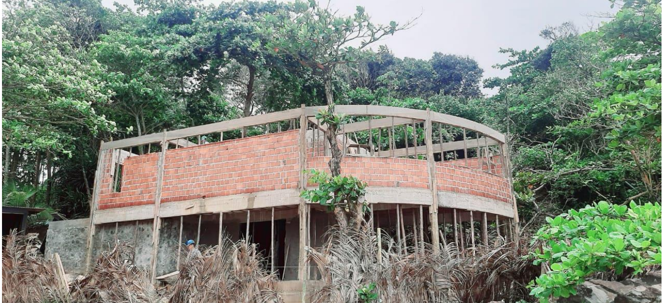
Foto 01 – Execução de alvenaria.
