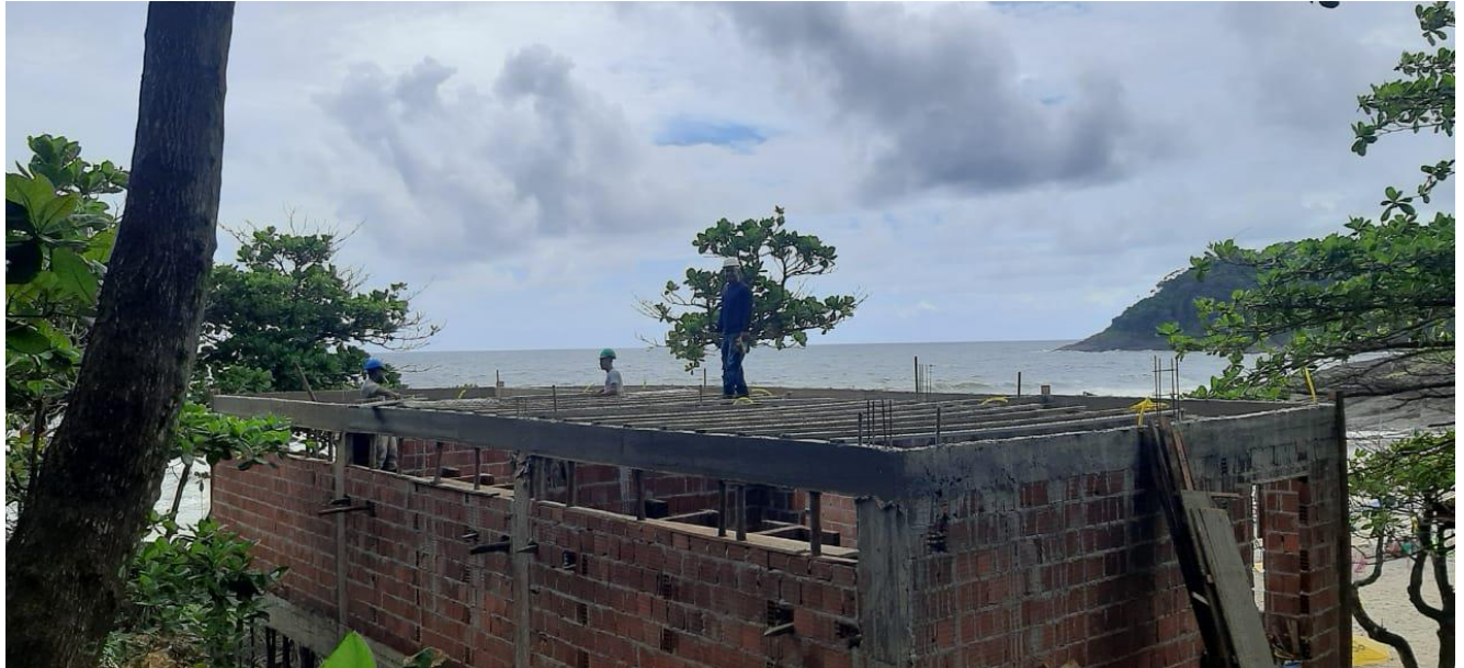
Foto 03 – Armação de laje em pavimento superior.
