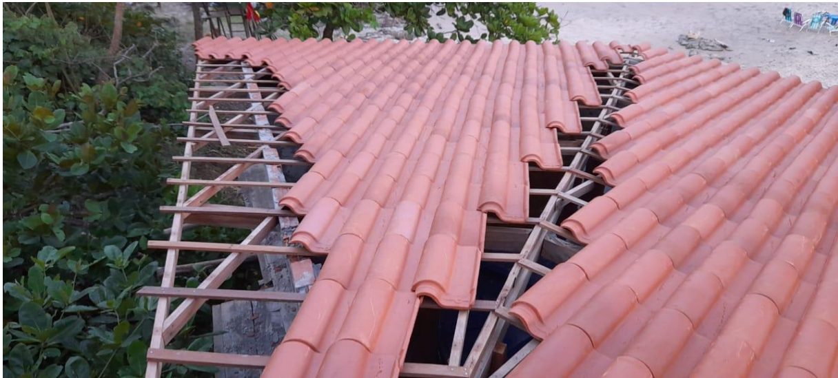
Foto 01 – Finalização da cobertura.
