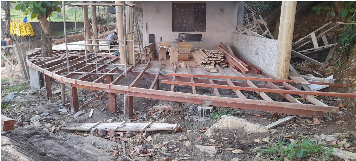
Foto 04 – Execução do DECK de madeira.
