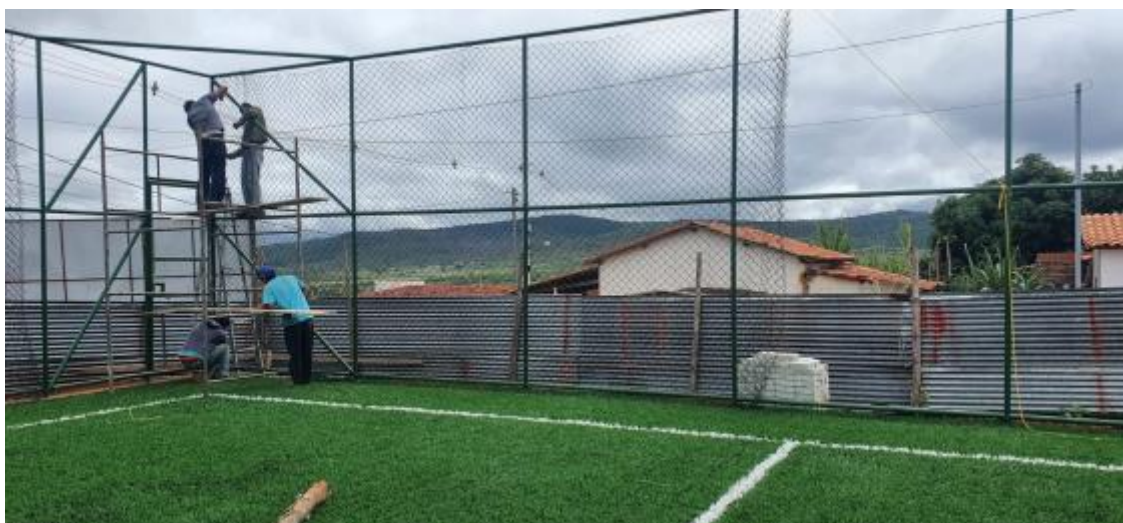
Foto 02 – Execução de alambrado.
