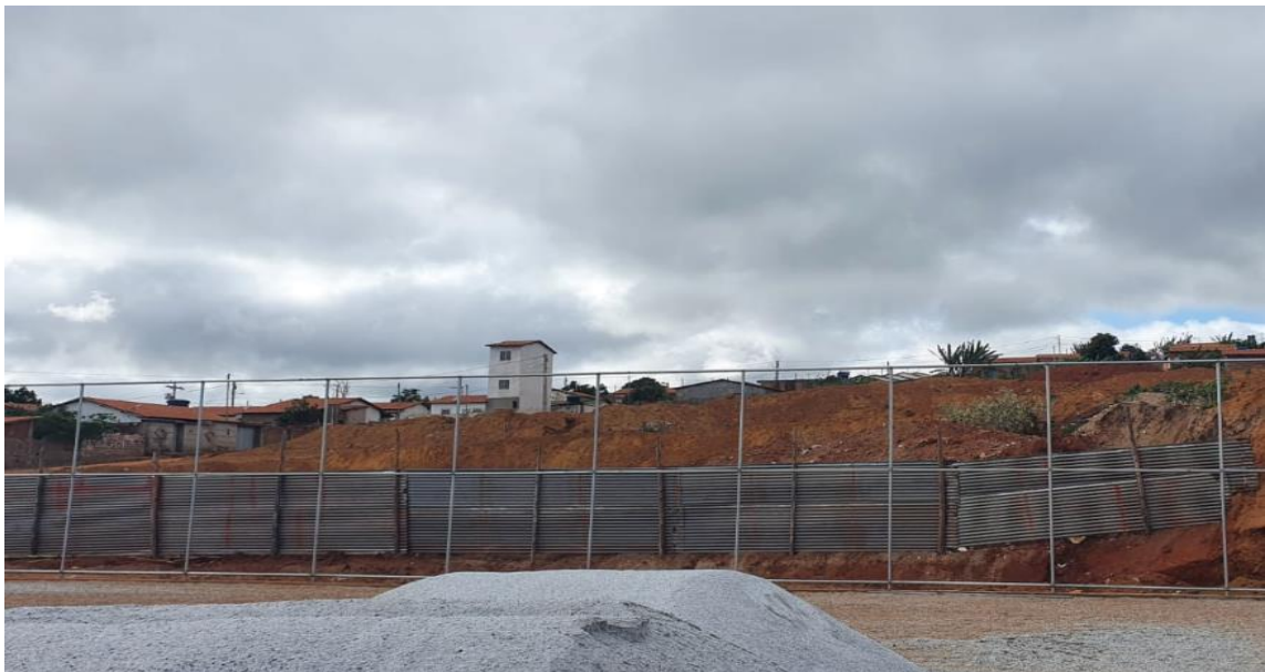
Foto 02 – Execução de Alambrado.
