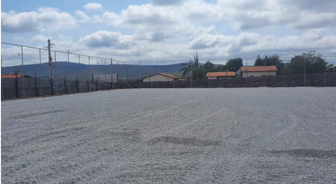
Foto 01 – Lançamento de camada de brita para execução de base da grama sintética.
