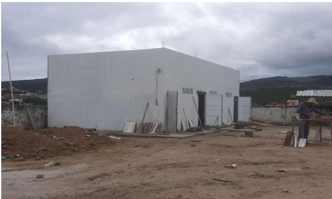
Foto 02 – Execução do vestiário.
