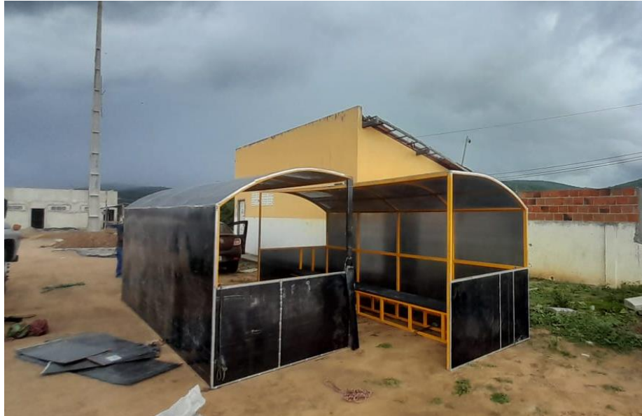
Foto 06 – Execução de mureta para alambrado.
