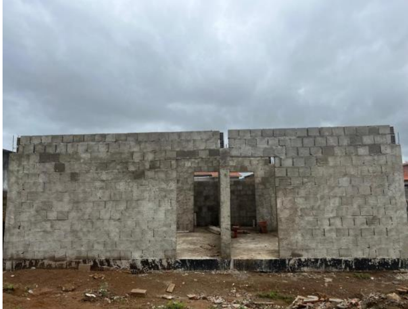
Foto 01 – Execução do Sanitário Público.
