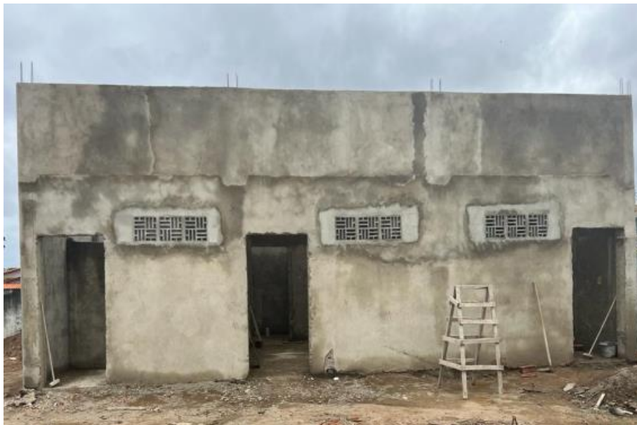
Foto 02 – Execução do vestiário.
