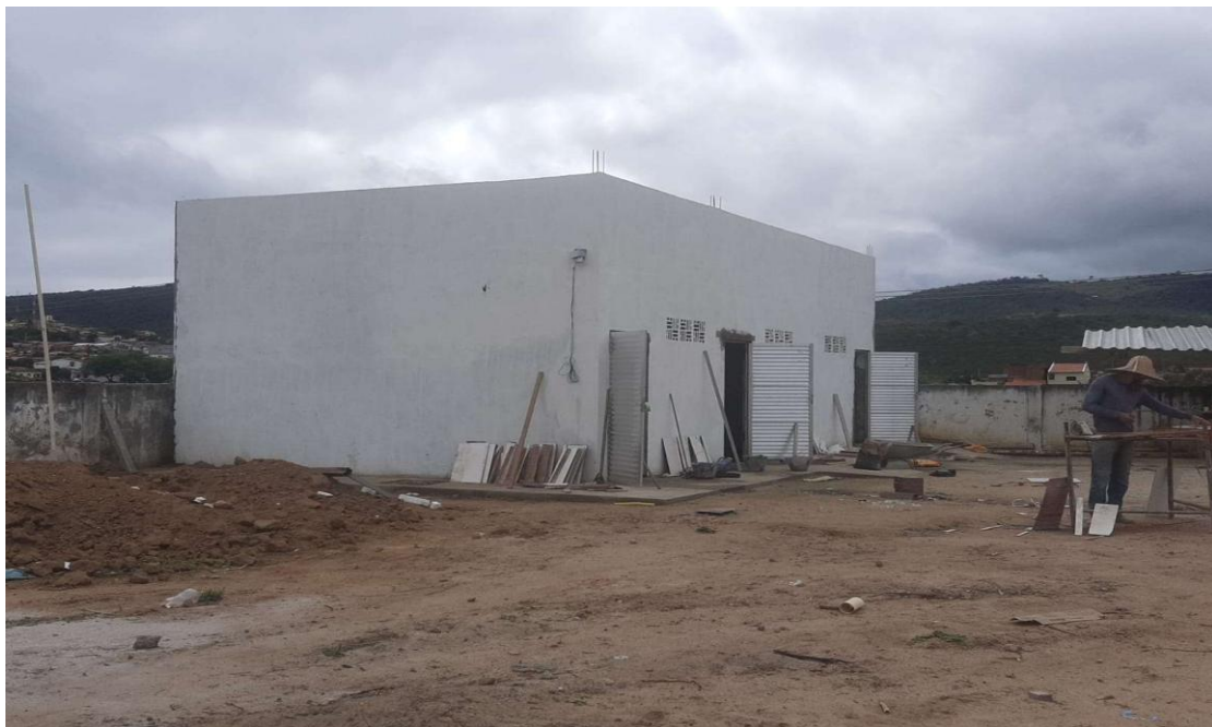
Foto 02 – Execução do vestiário.
