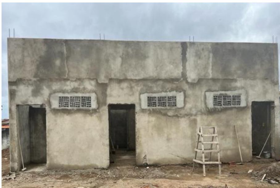
Foto 02 – Execução do vestiário.
