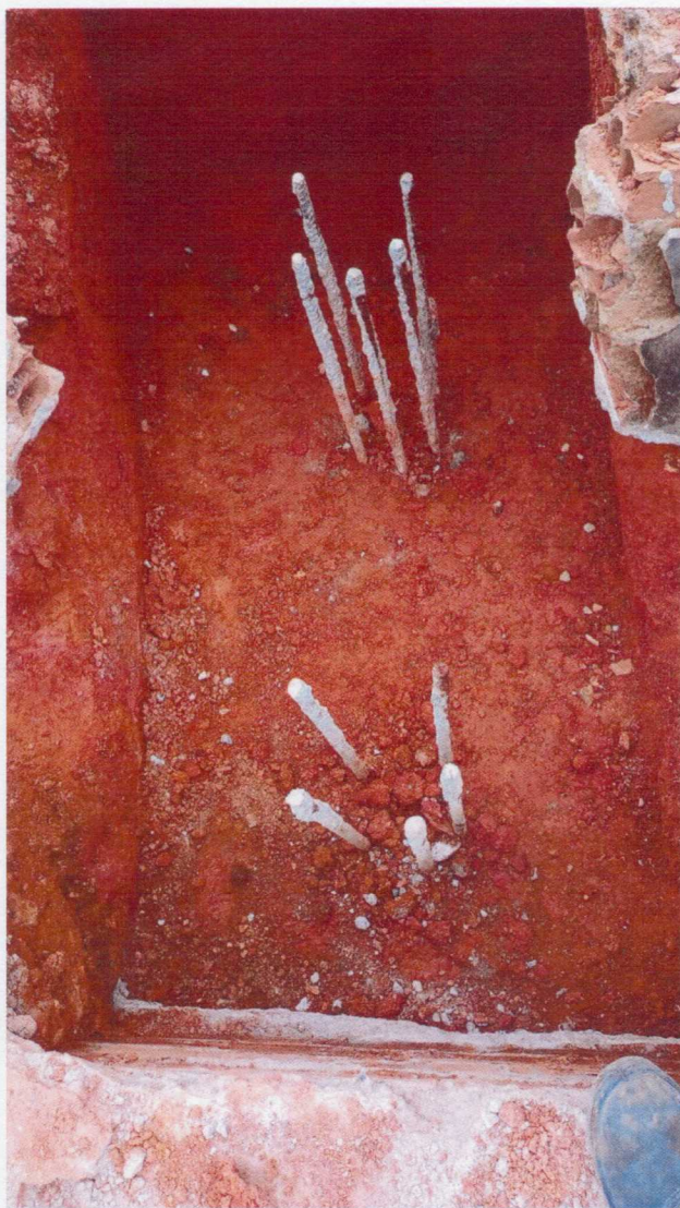
Foto 03 – Vista 03 da fundação em estacas da cobertura metálica:
