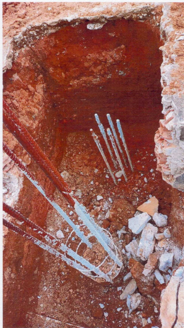
Foto 04 – Vista 04 da fundação em estacas da cobertura metálica:
