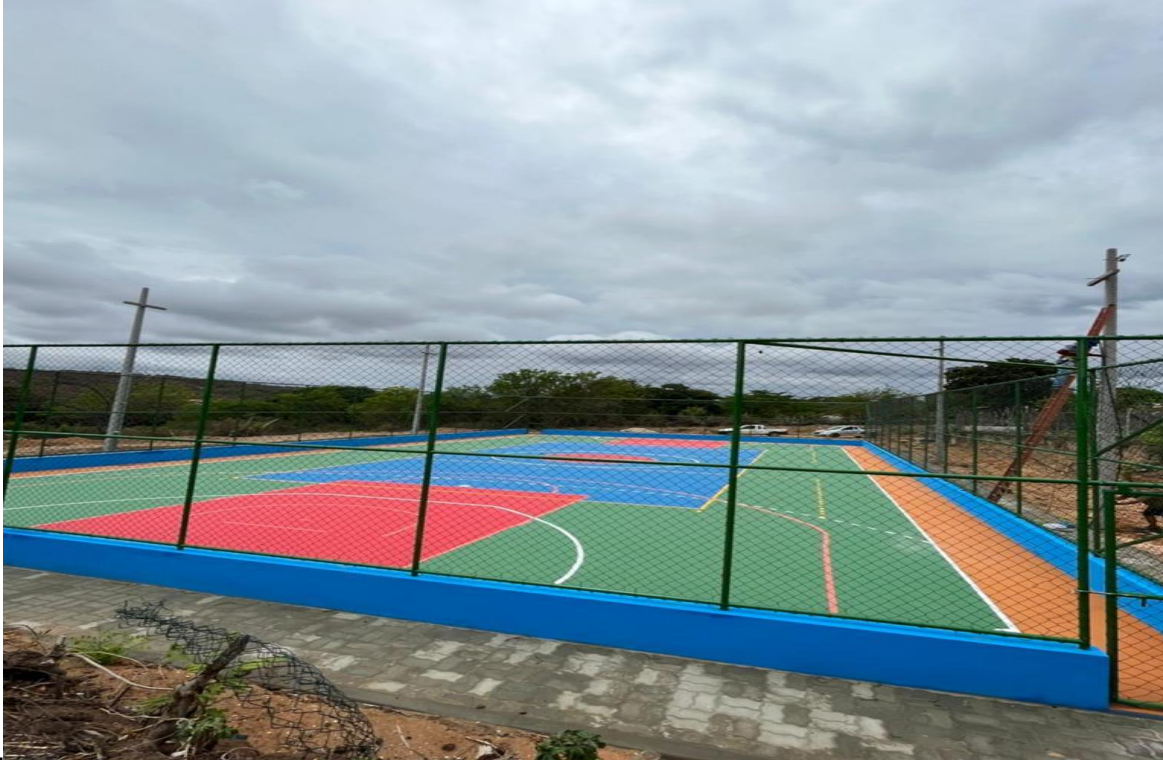
Foto 01 – Execução de piso intertravado.
