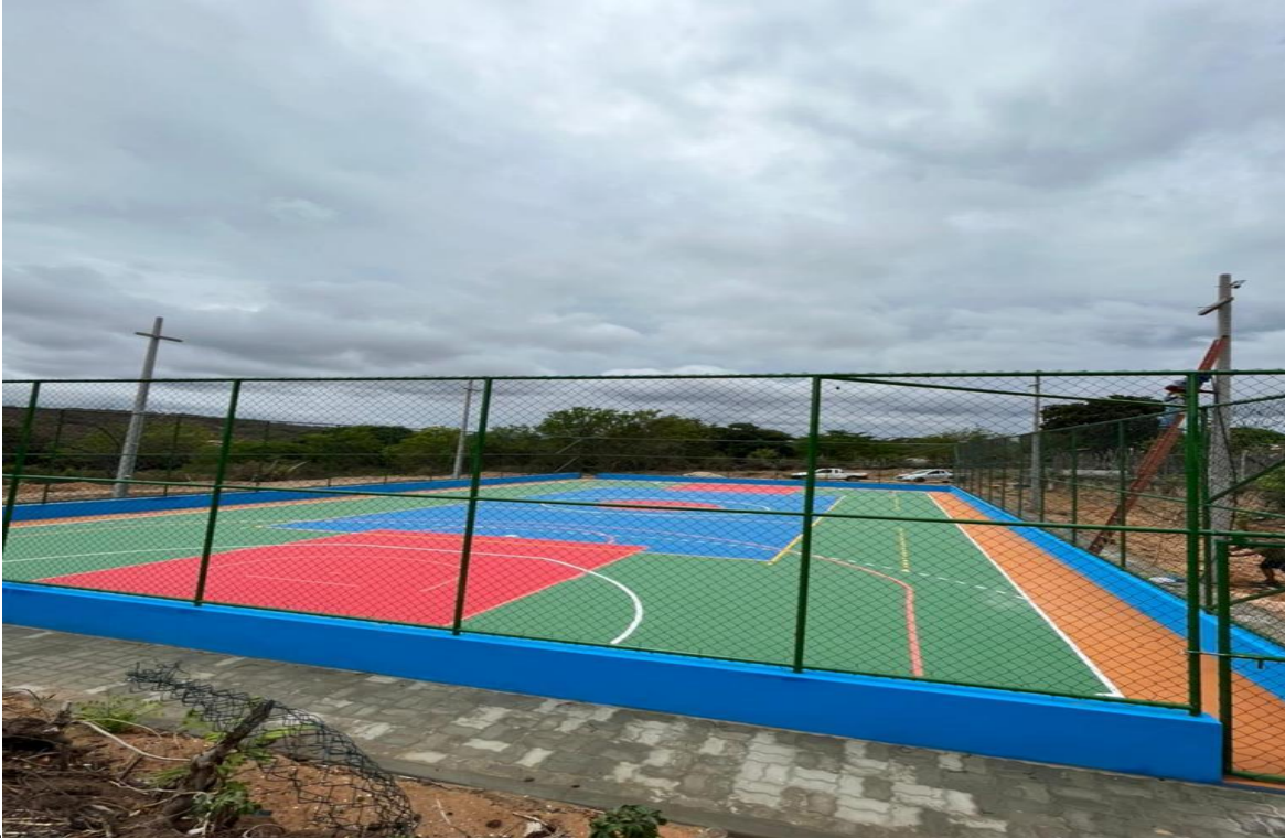
Foto 01 – Execução de piso intertravado.
