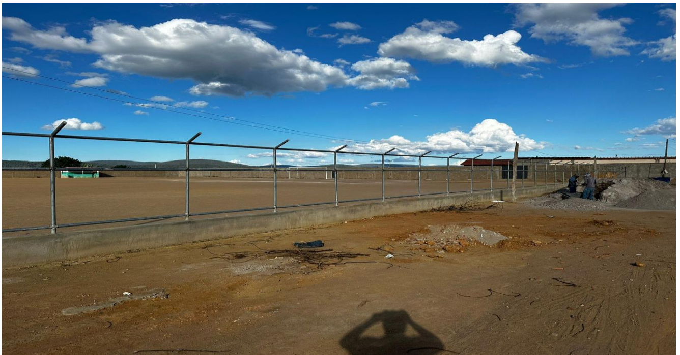
FOTO 02 – Execução de alambrado.
