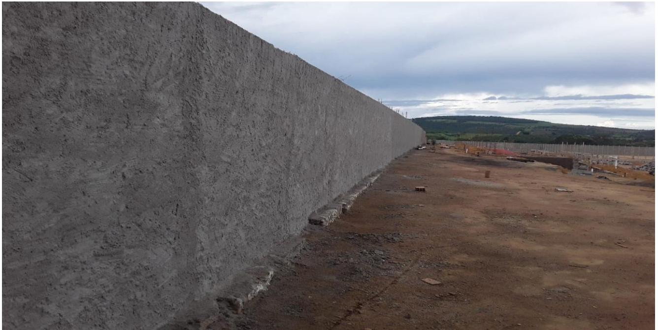
FOTO 01- Construção de muro.
