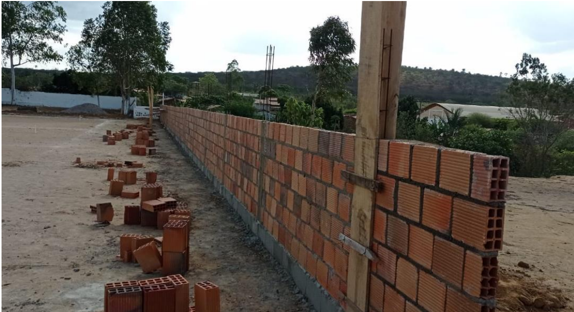
FOTO 01- Construção de muro.
