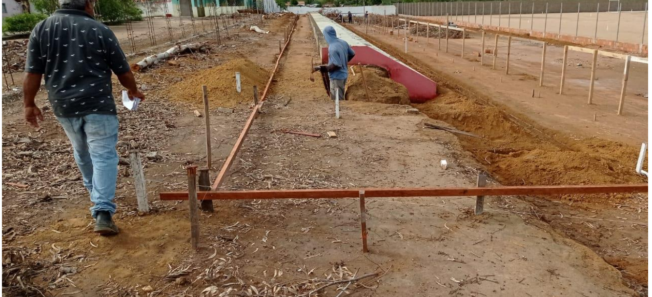
FOTO 03 – Execução de gabarito e escavação para construção de arquibancada.
