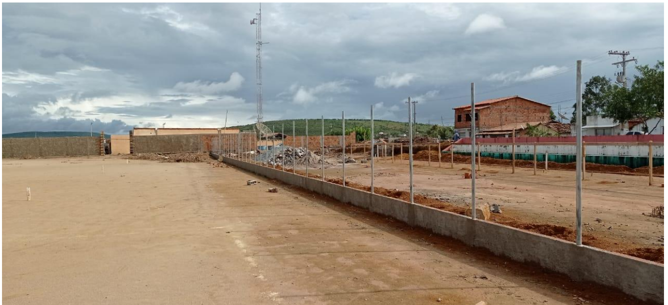
FOTO 02 – Execução de alambrado.
