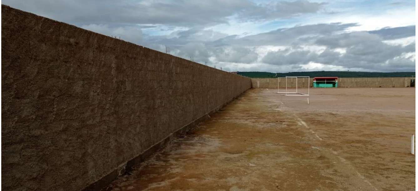
FOTO 01- Construção de muro.
