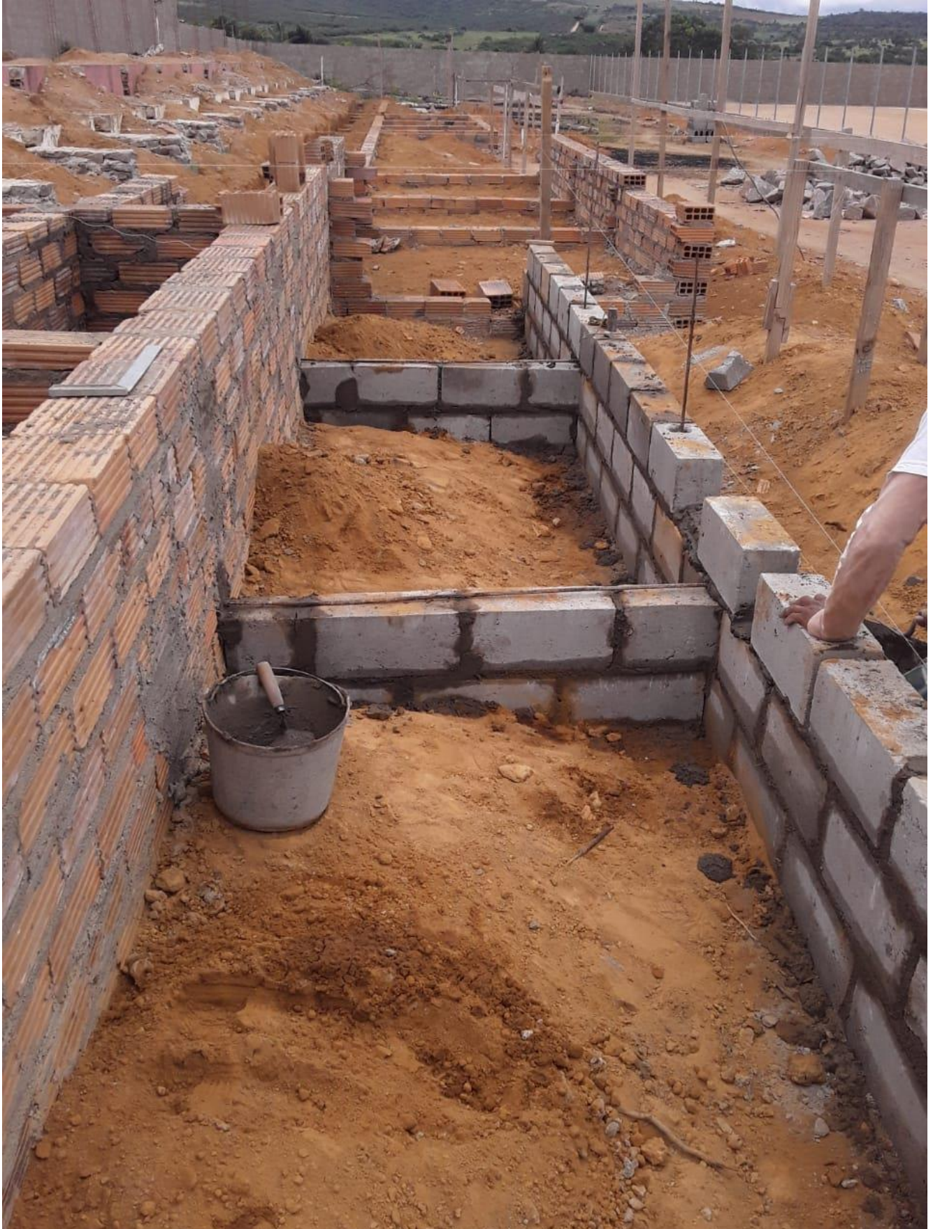
FOTO 04- Arquibancada em andamento.
