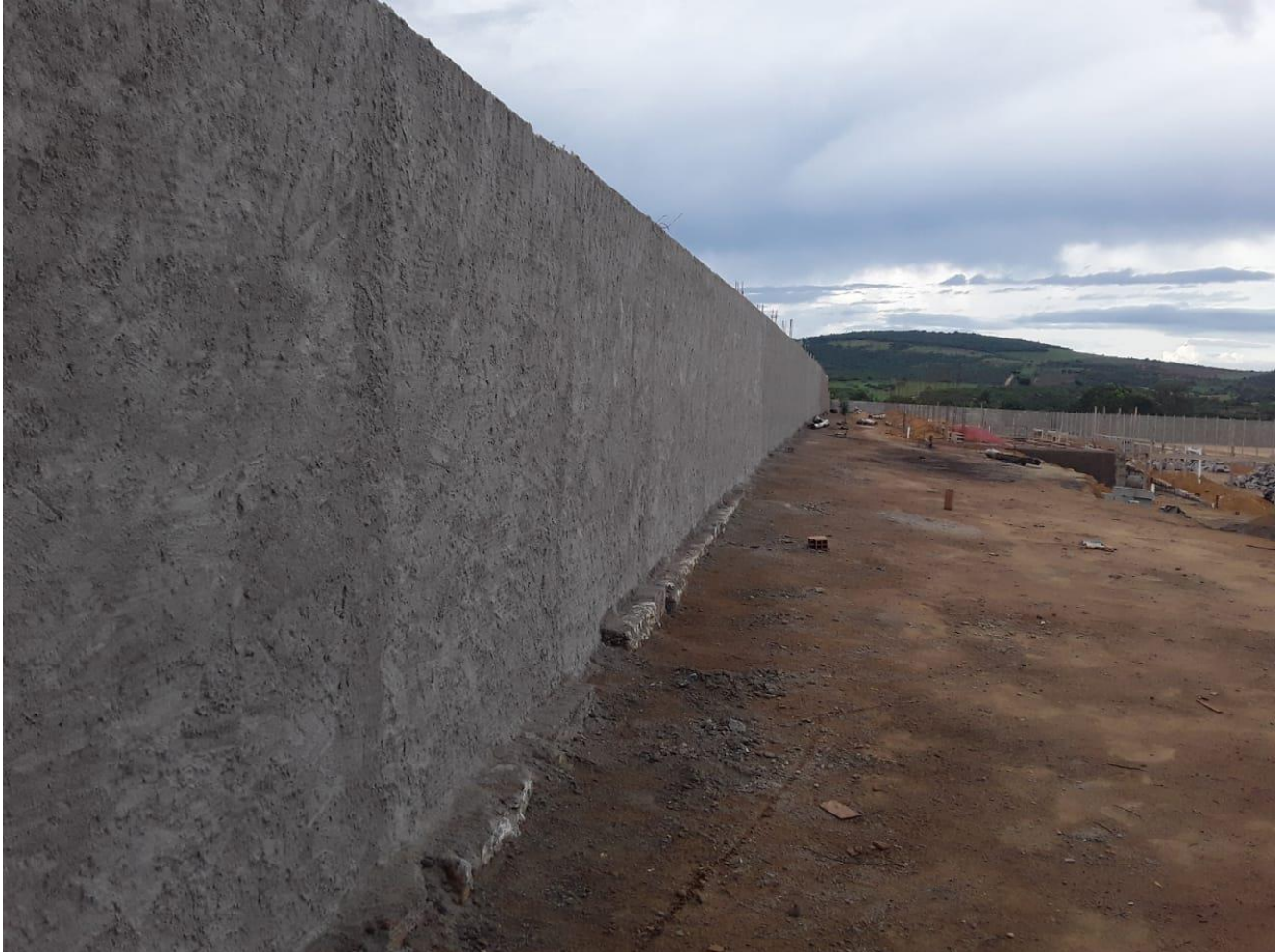
FOTO 01- Construção de muro.
