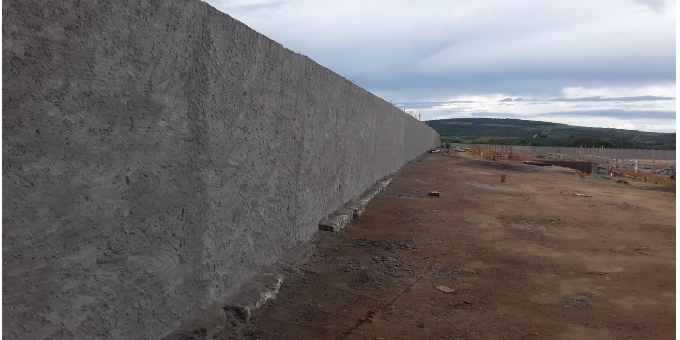
FOTO 01- Construção de muro.
