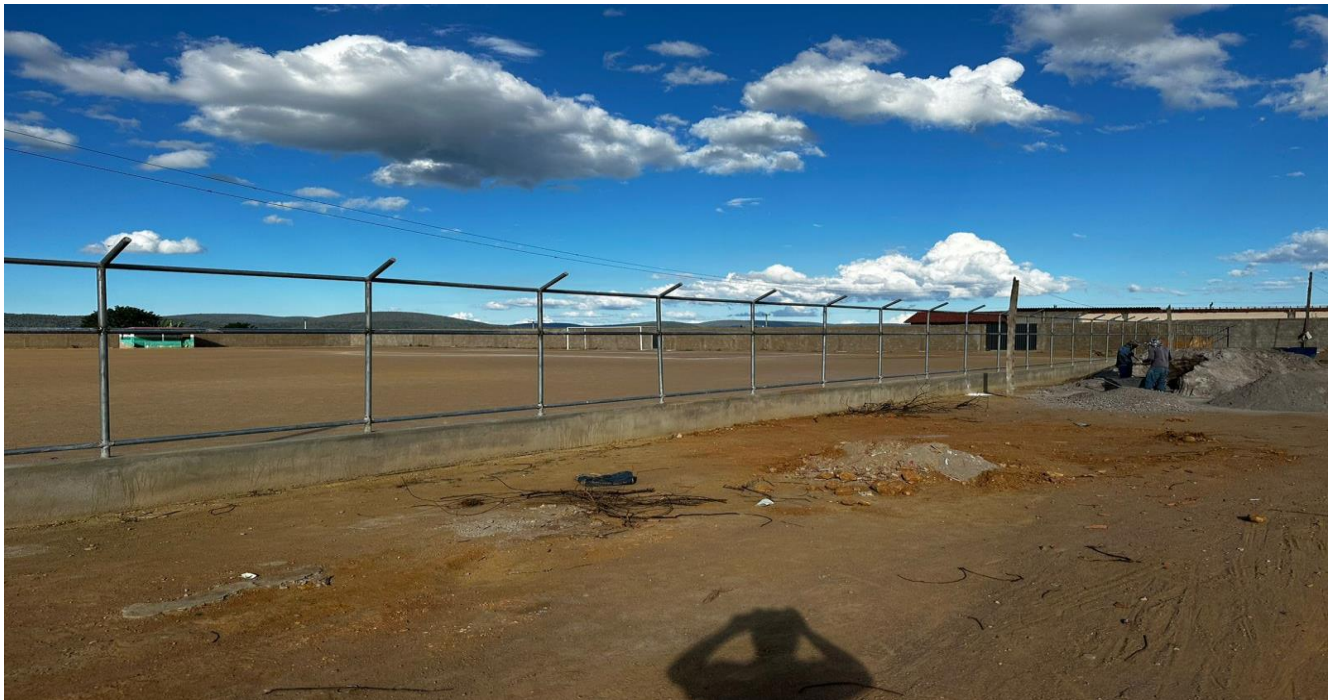
FOTO 02 – Execução de alambrado.
