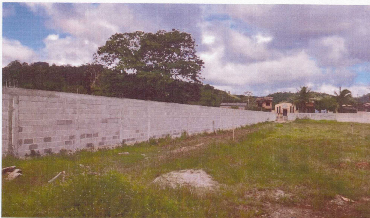
Foto 02 – construção do muro.
