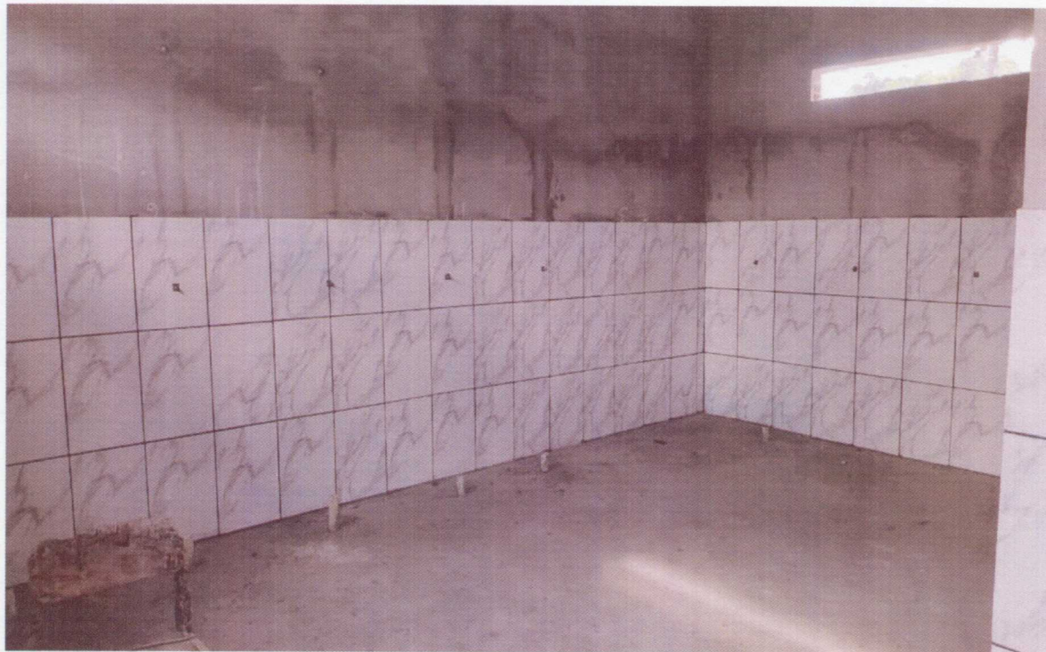
Foto 05 – vestiário área interna.
