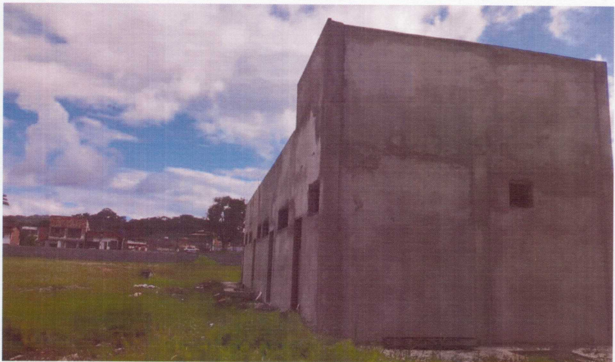
Foto 04 – Construção do vestiário, área externa.
