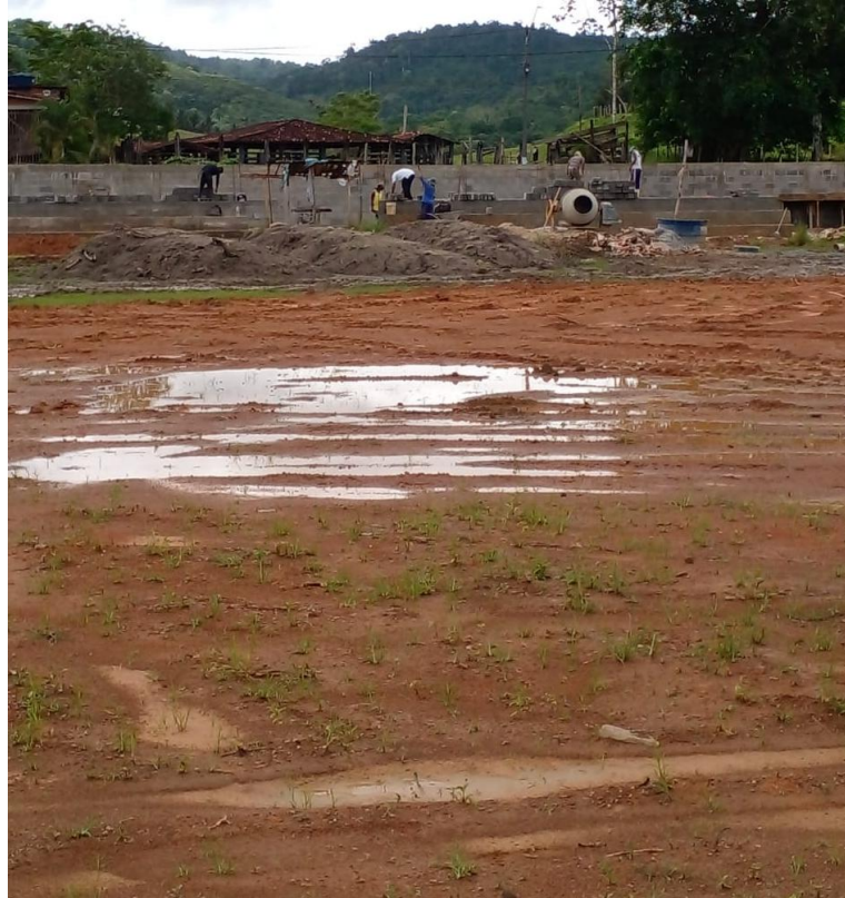
Foto 01 – Implantação geral da obra.
