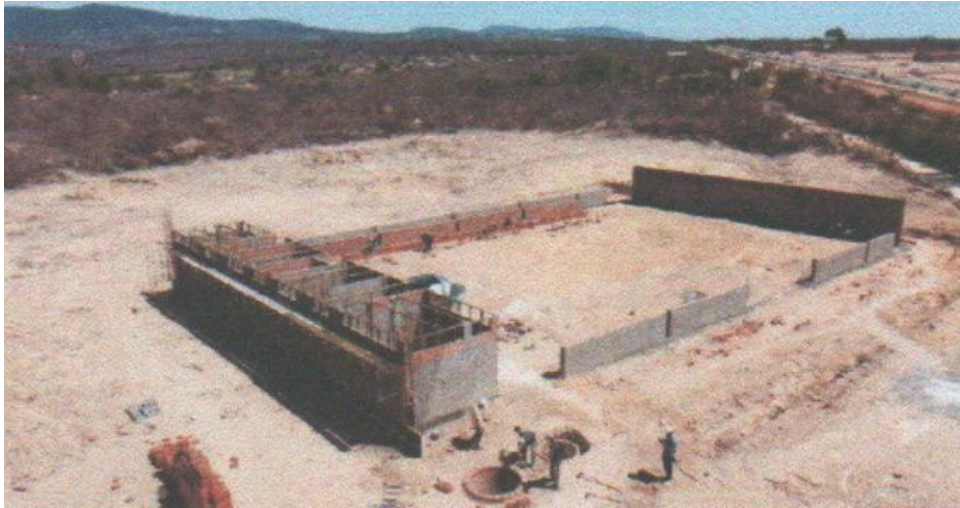
Foto 02 – EXECUÇÃO DE QUADRA POLIESPORTIVA NO BAIRRO BARREIRINHO
